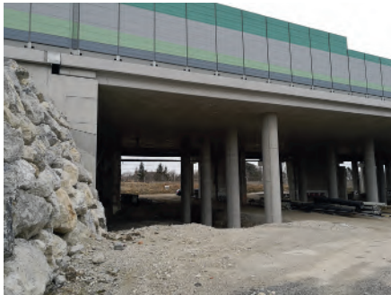
Ansicht Randfeld Bendabrücke
