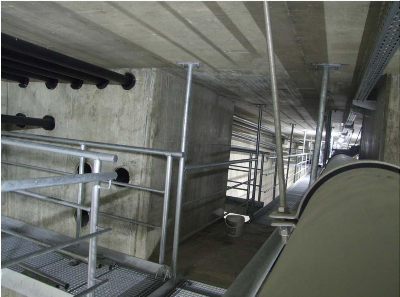
Fig. 4 Wartungsstege Hohlkasten Weidatalbrücke
