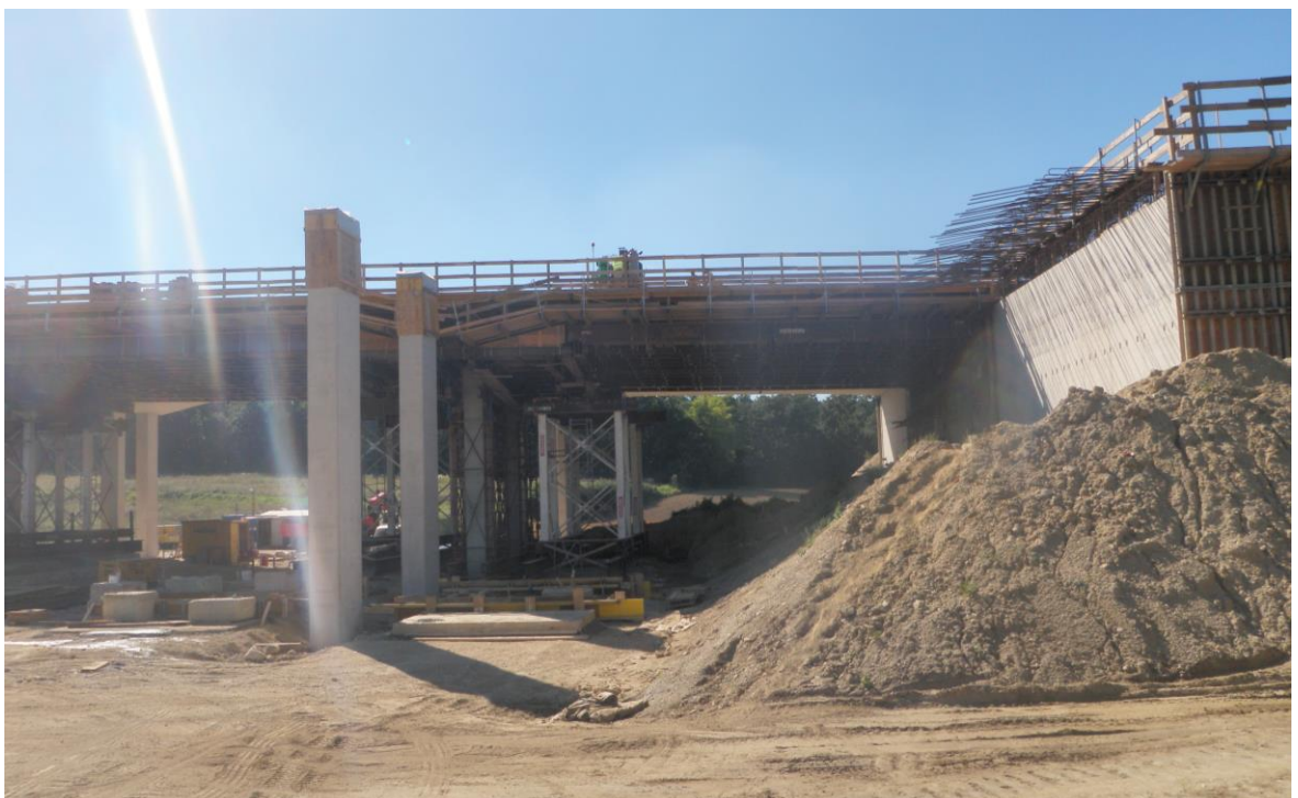
Abbildung 23: Tragwerk RFB Wien noch eingerüstet.
