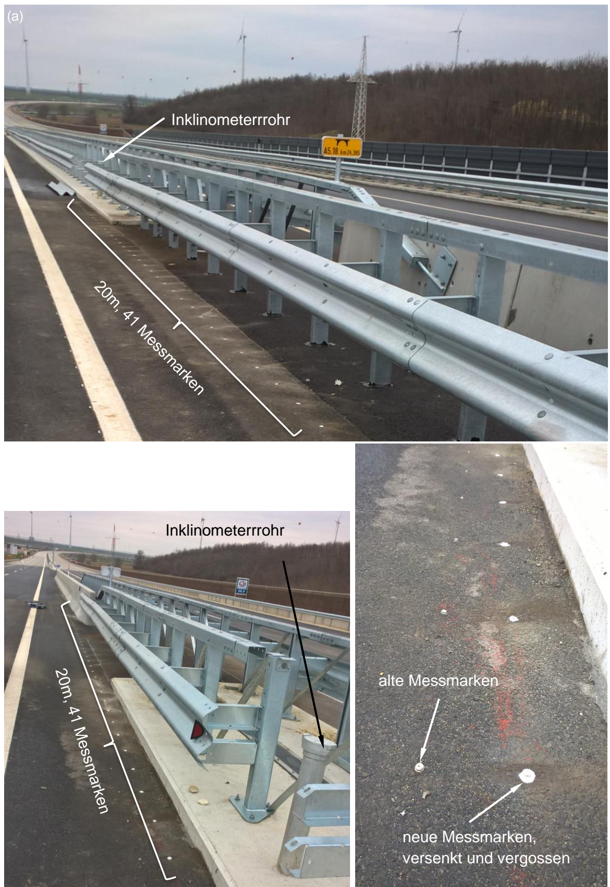
Abbildung 26: 41 Messmarken NEU 0,20m vom Fahrbahnrand, alle 0,50m über 20m Länge je RFB nahe Innenstreifen (a) RFB-Wien (b) RFB-Staatsgrenze, Nullmessung - Präzisionsmessung mit Setzdehnungsmessgerät am 06.12.2017.
