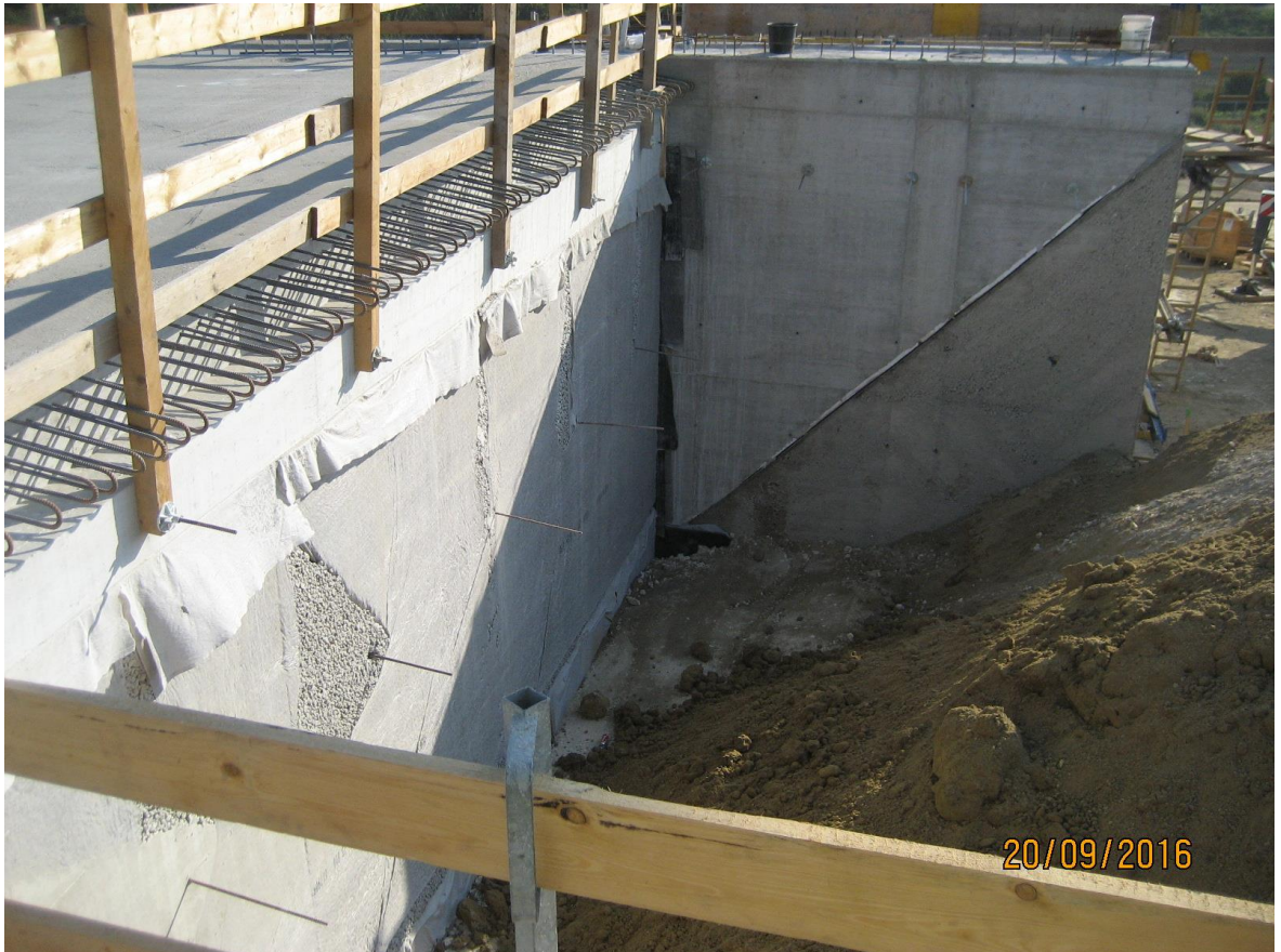
Abbildung 22: Widerlager noch nicht eingeschüttet
