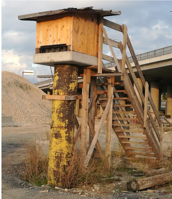
Abbildungen 12: Laserstation bei B2309
