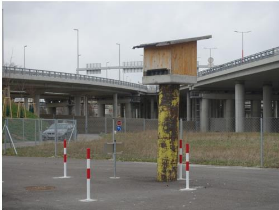
Laserstation eingezäunt in GSA
