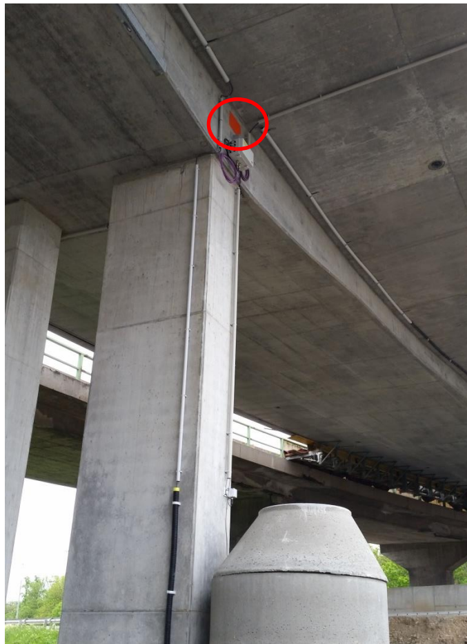
Abbildungen 13: Anordnung der Reflektorplatte in Achse 4
