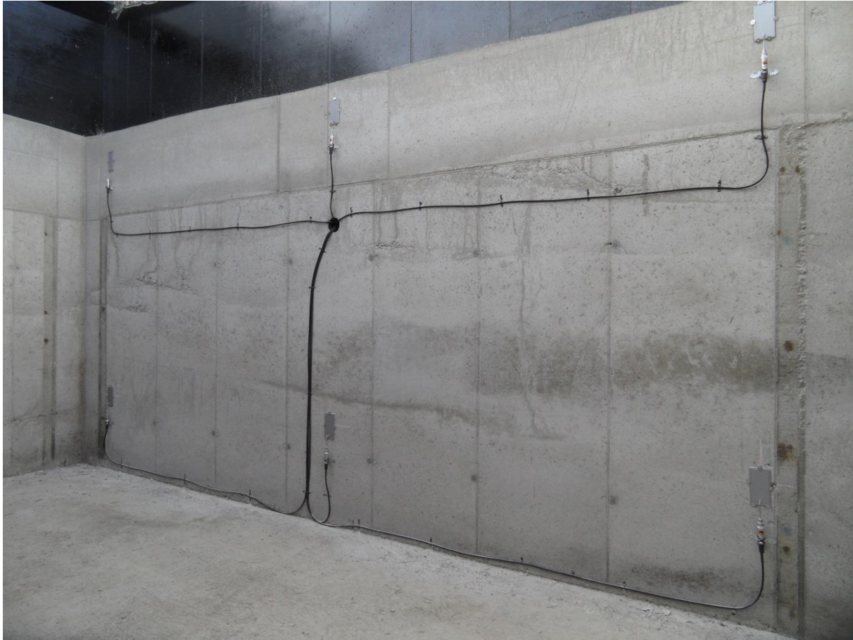
Abbildung 18: Montage der Erddruckgeber im Widerlager Achse 6
